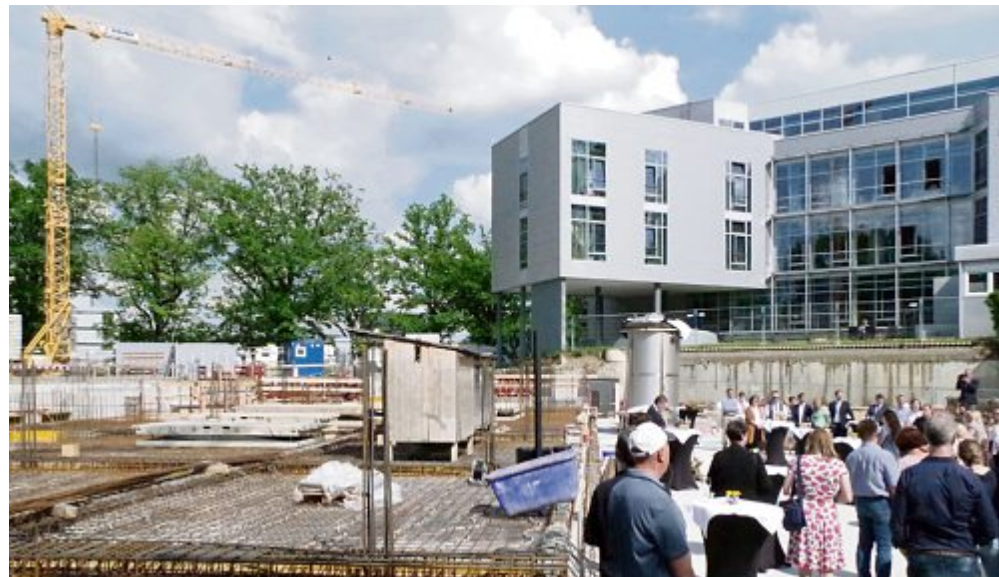
Anschließend an das Bestandsgebäude Bau A entsteht in den kommenden zwei Jahren ein Gesundheitszentrum sowie Betreutes Wohnen für katholische Geistliche im Ruhestand. Fotos: Reder
