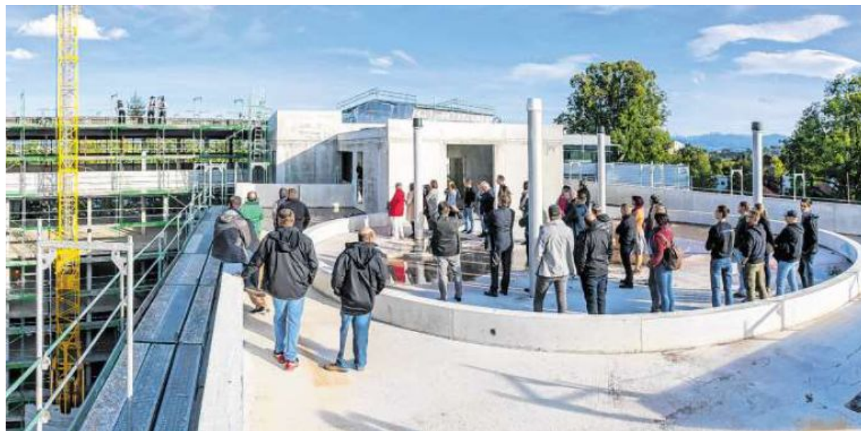
Richtfest für die Erweiterung des Gesundheitszentrums und einen einmaligen Priester-Ruhesitz an der Robert-Weixler-Straße. Auf dem Dachgeschoss (rechts) entsteht eine Rundkapelle aus Holz. Foto: Ralf Lienert
